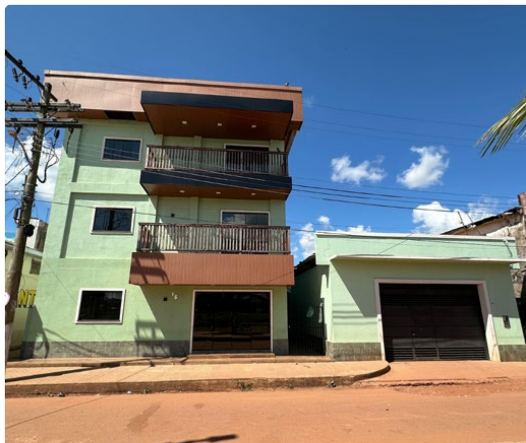
Vista da fachada do Hotel Floresta após a conclusão da reforma. Foto: Pedro Adnet
