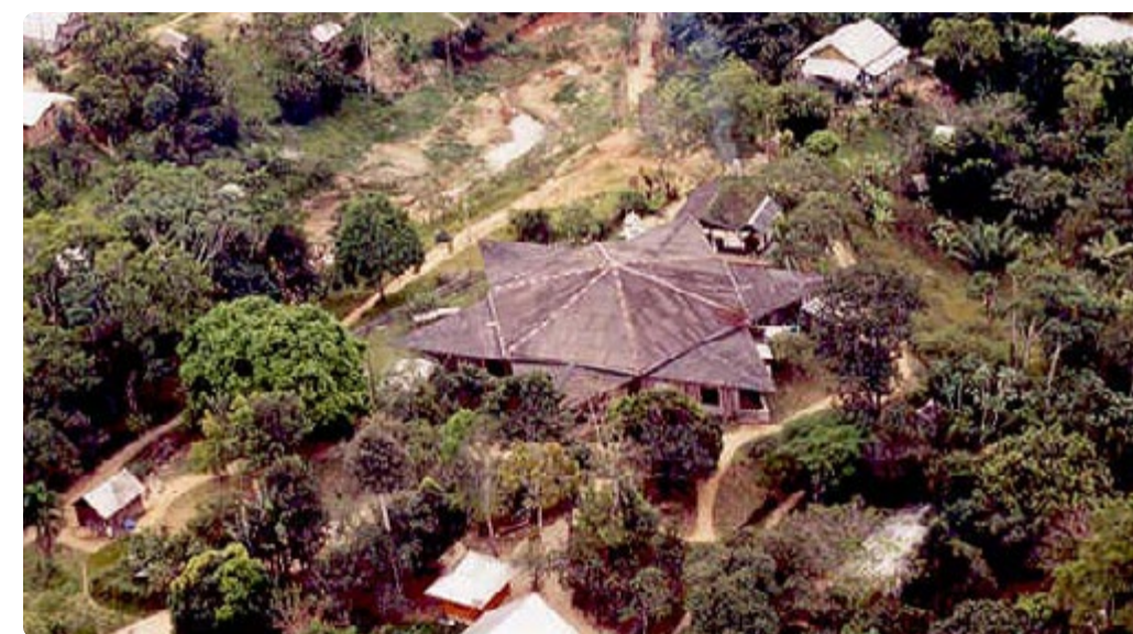
Vista aérea da antiga Igreja Matriz, construída entre os anos de 1987 e 1989. Foto: Acervo CEDOC
