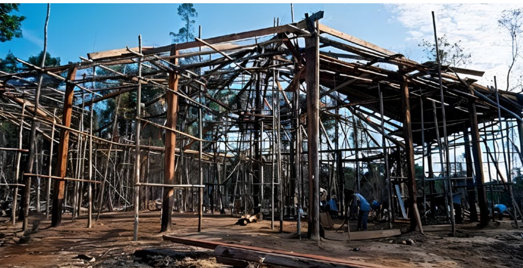
Construção da antiga igreja, no final dos anos 80, utilizando-se a madeira e a força de trabalho locais. Foto: Acervo CEDOC.
