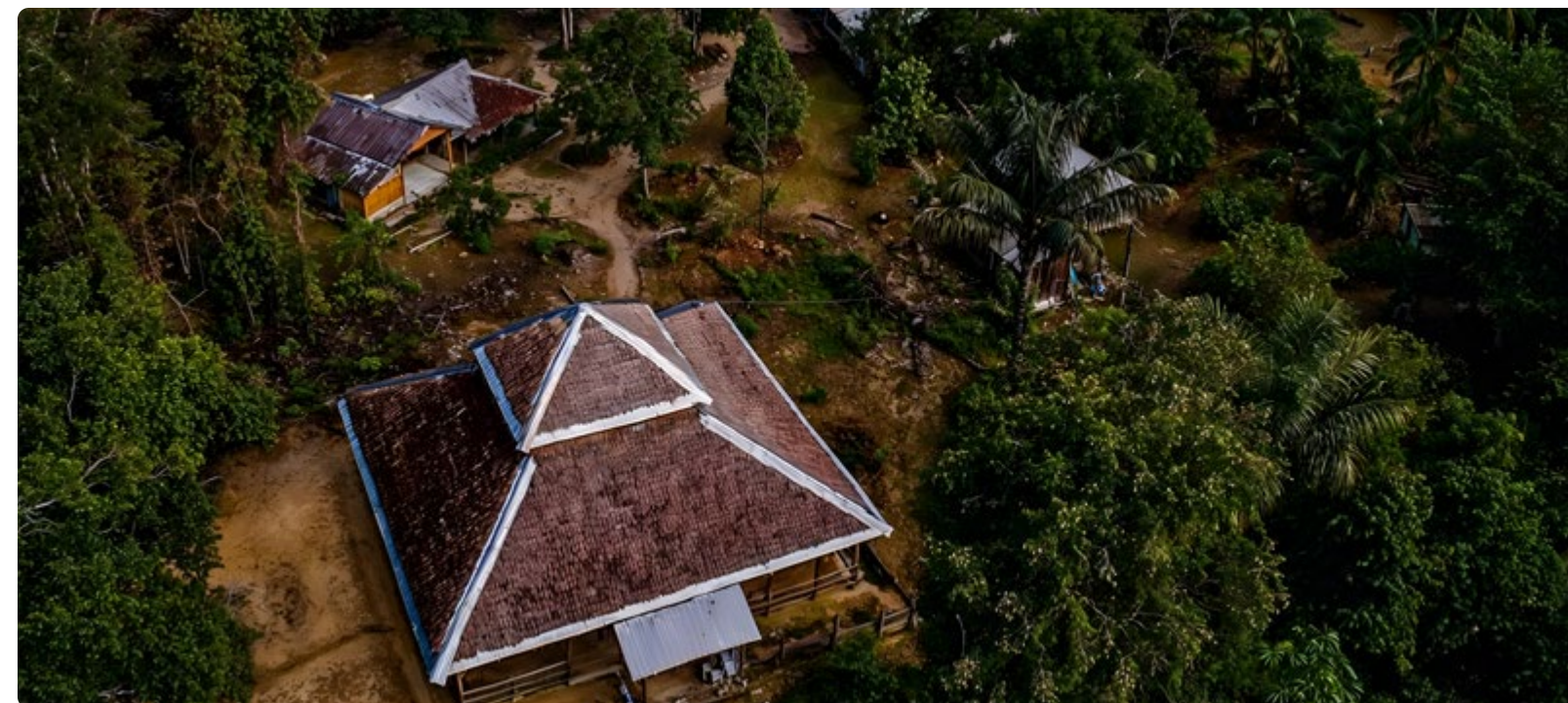
Fotografia aérea de parte da estrutura da Santa Casa. Foto: Pedro Adnet
