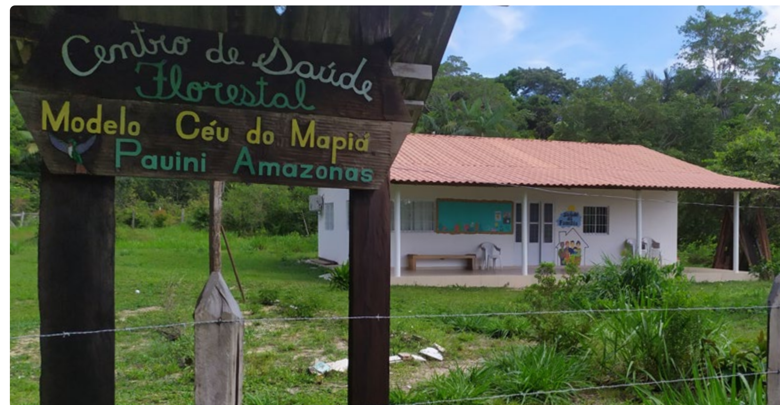
Centro de Saúde Florestal após ser reformado e reestruturado. Foto: Pedro Adnet
